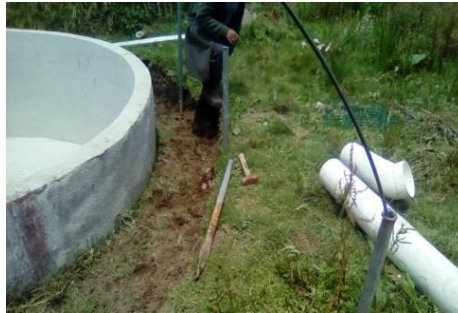
Figura 8. Colocación de estructura de varilla
