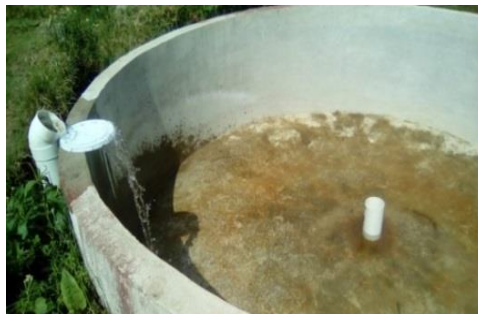
Figura 9. Llenado de estanque con agua de las truchas
