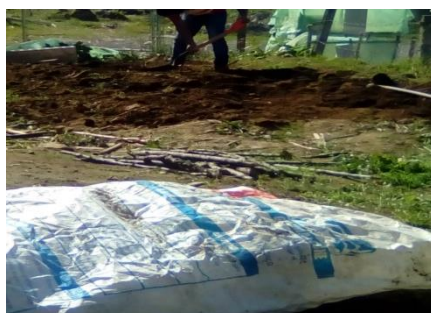
Figura 15. Acondicionamiento de espacio
